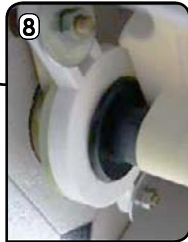
Tubería de drenaje debe entrar hasta que se encuentre con la parada dentro de la caja trampa
