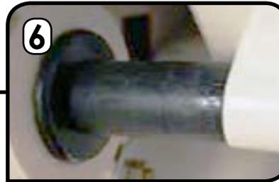
Con orinal en la pared. Prueba de ajuste la correcta alineación
