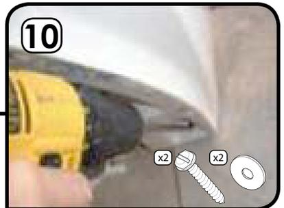
Usando las dos arandelas de goma y los dos tornillos de 1.5" ( 38.1 mm ), ancla la parte inferior de urinario a la pared.
